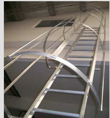
FIJACIONES CON BULON Y TCA.AUTOFRENANTE
